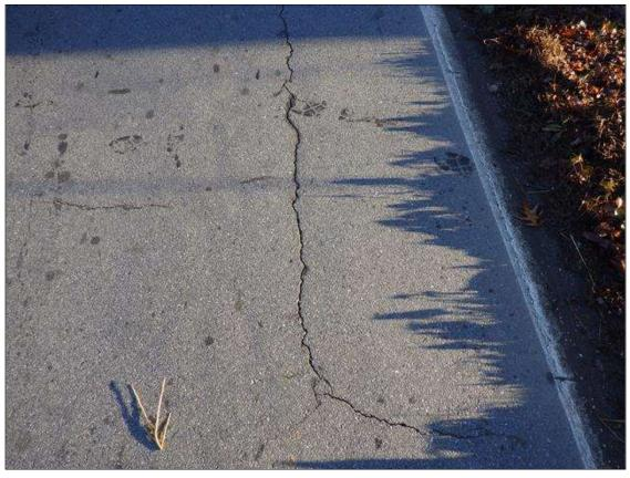
(2) LONGITUDINAL CRACKS UP TO INTERMITTENT 40 FEET LONG IN THE NORTHBOUND LANE OF THE NORTH APPROACH AT END BENT 2
